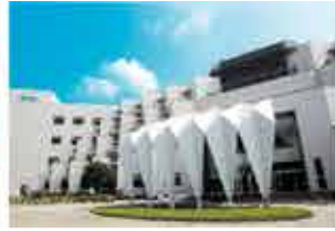
台南研發中心 (鑽石級綠建築)
